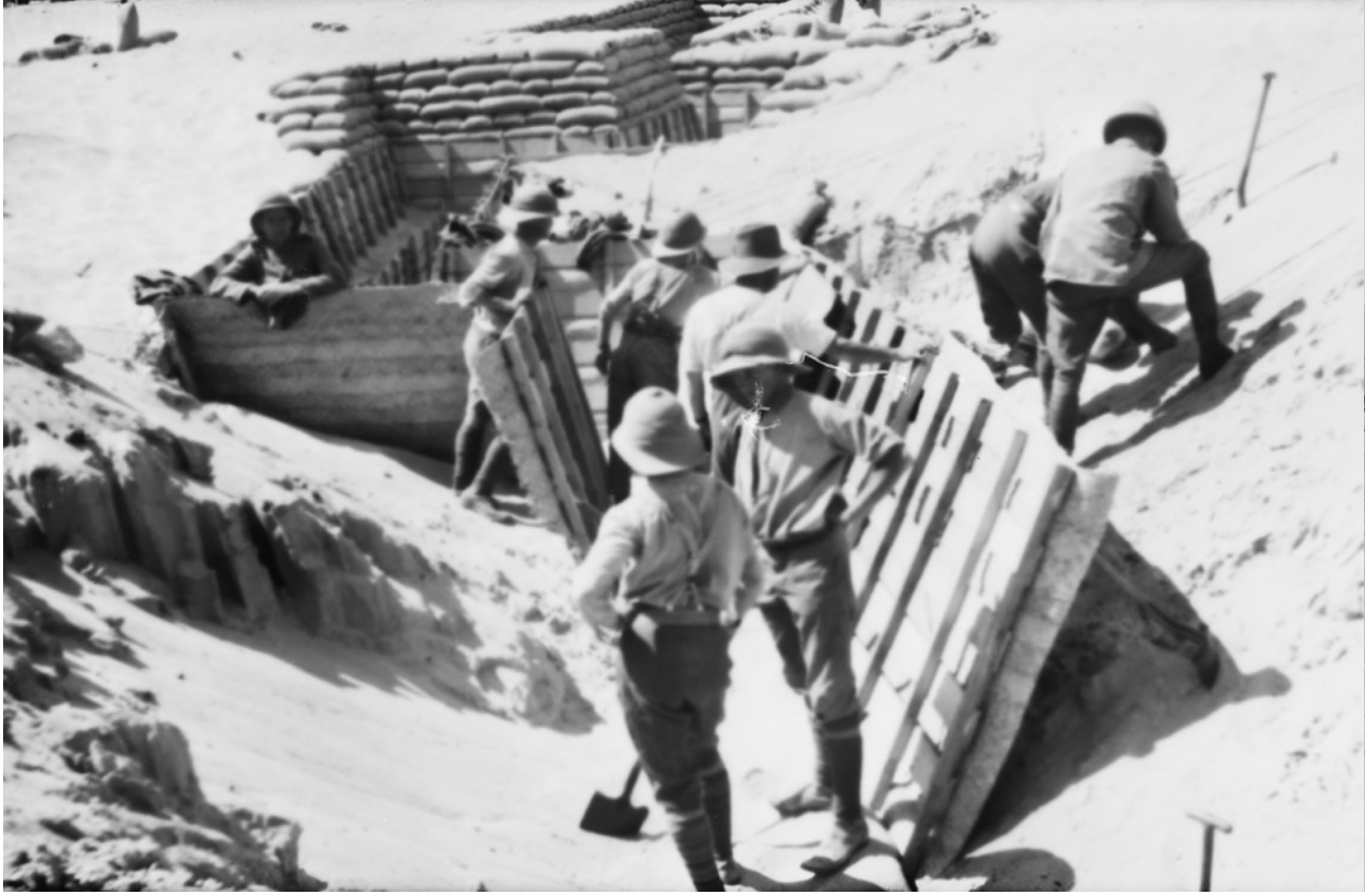
▲ Avustralyalı askerler Süveyş Kanalı'na yönelik Osmanlı akınlarına karşı ileri emniyet hattını inşa ederken. Fotoğrafta görüldüğü gibi gevşek kumda mevzileri inşa ederken bol miktarda kum torbası, kereste ve sac kullanılması gerekir. Osmanlı ordusunda bu tahkim malzemesi yeteri kadar mevcut olmadığı için Osmanlı mevzileri iklim ve düşman atışlarına karşı dayanıklı değildi.
