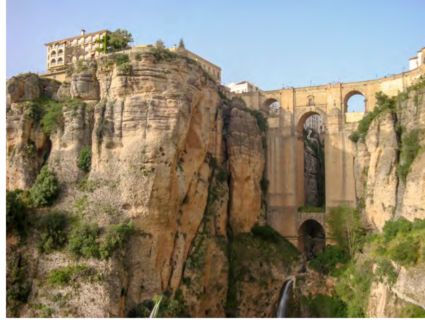
▲ Puente Nuevo - Malaga / Endülüs
